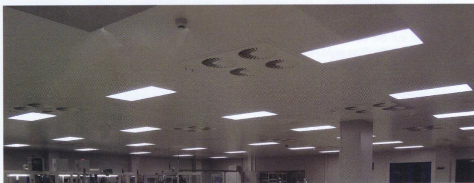
Da die gesamte Sauberraumdecke einschließlich Installationen, Klimatechnik und Lüftung an die Hallendach-Konstruktion gehängt wurde, blieben ebm-papst teure Fundamentarbeiten und eine aufwändige Stahlbaukonstruktion erspart.
